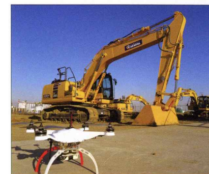
●ICT油圧ショベル ※ドローンは測量に使用
