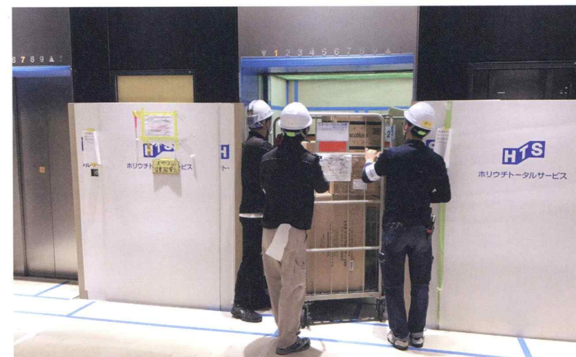
現場作業のスペシャリストが滞りなく作業を進めました
