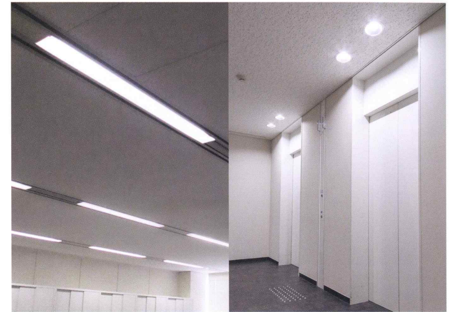
オフィス部分はシステム天井用照明器具の入れ替えを実施 共用部はLEDダウンライトに入れ替えました
