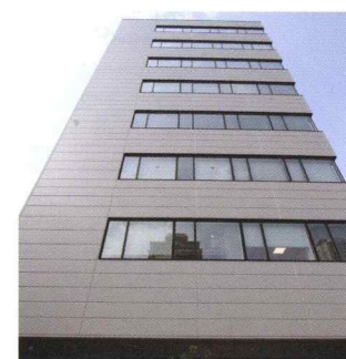
近鉄上本町石ヶ辻ビル
