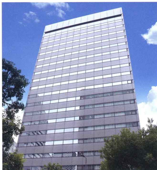
近鉄堂島ビル(大阪市北区) Osaka Metro四つ橋線「西梅田」駅徒歩3分、JR東西線「北新地」駅徒歩3分
