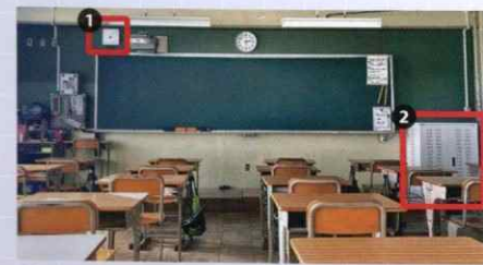
①無線AP ②充電保管庫が設置された教室
