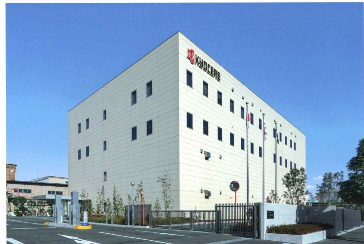
⑤京セラ 川崎工場 ■電気 ■計装 ■情報通信 ■空調・衛生
