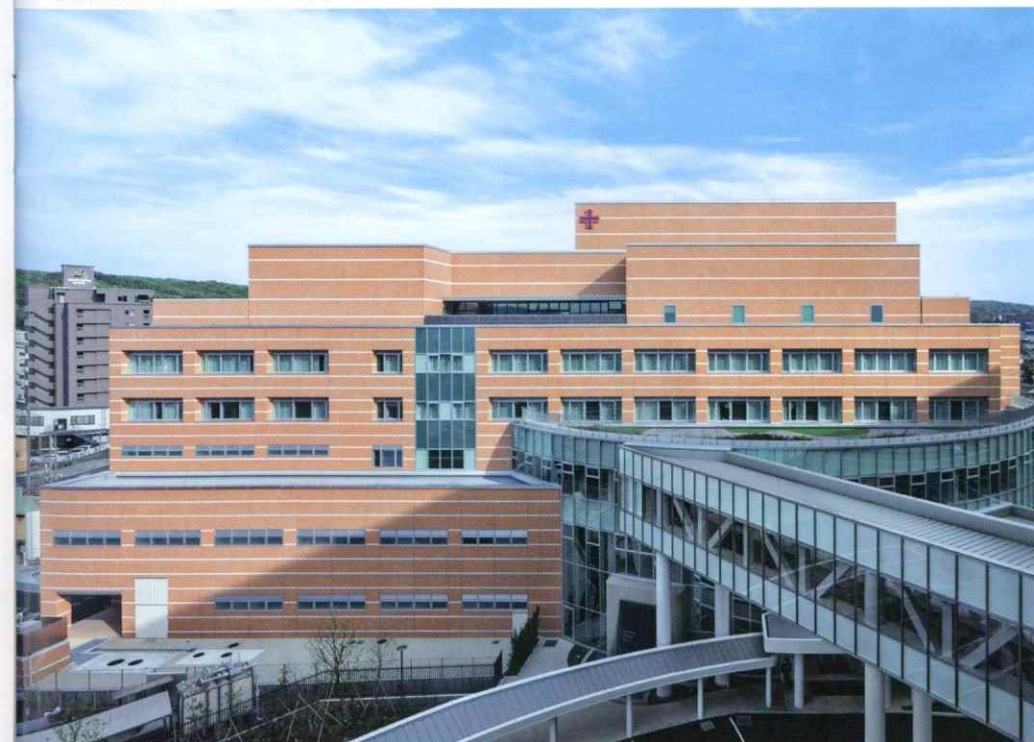
⑦ 倉敷成人病センター ■電気 ■情報通信 ■空調・衛生
