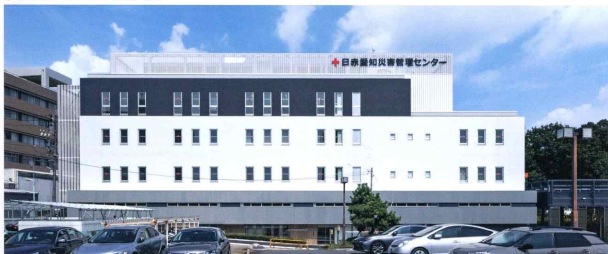
③ 日赤愛知災害管理センター棟 ■電気 ■計装 ■情報通信
