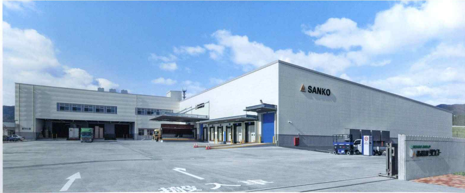
①サンコー 徳島工場 ■電気 ■情報通信 ■空調・衛生
