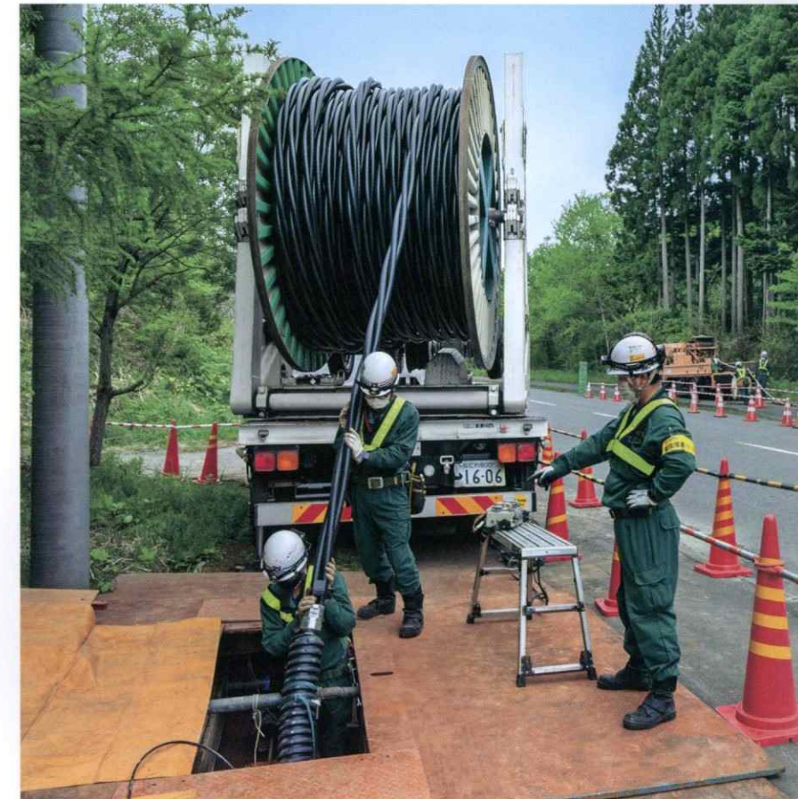
③ 函館南茅部地熱発電所 33kV自営線工事(北海道)
