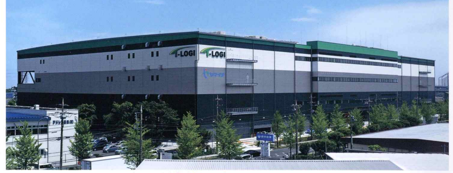
④T-LOGI久喜 ■電気■情報通信■空調・衛生
