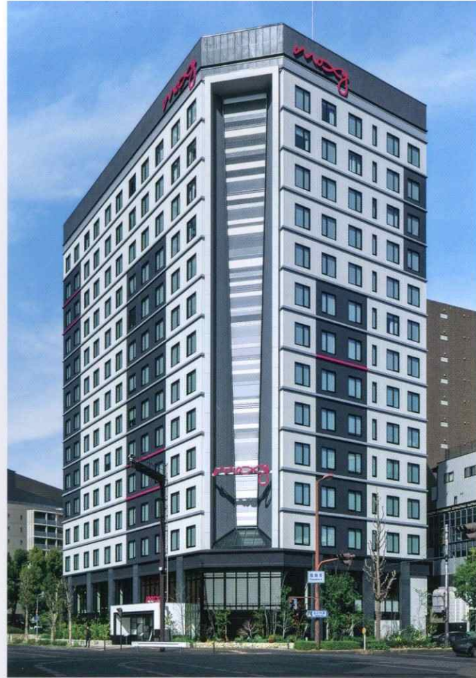
①モクシー大阪新梅田 ■電気 ■情報通信 ■空調・衛生
