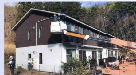
村内での施工風景
