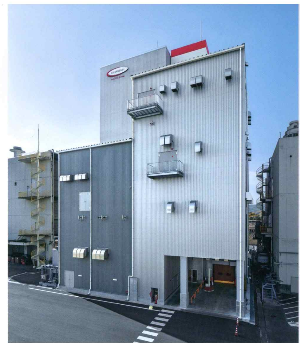
④林原 岡山第二工場 新プラン・酵素棟 ■電気 ■計装 ■情報通信
