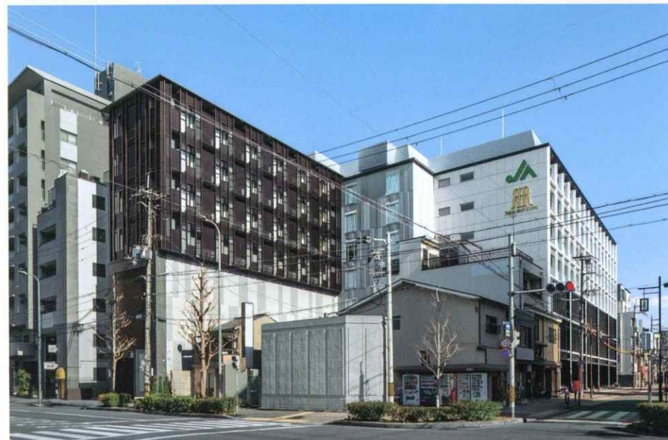
②京都JAビル リーガグラン京都 ■電気■情報通信
