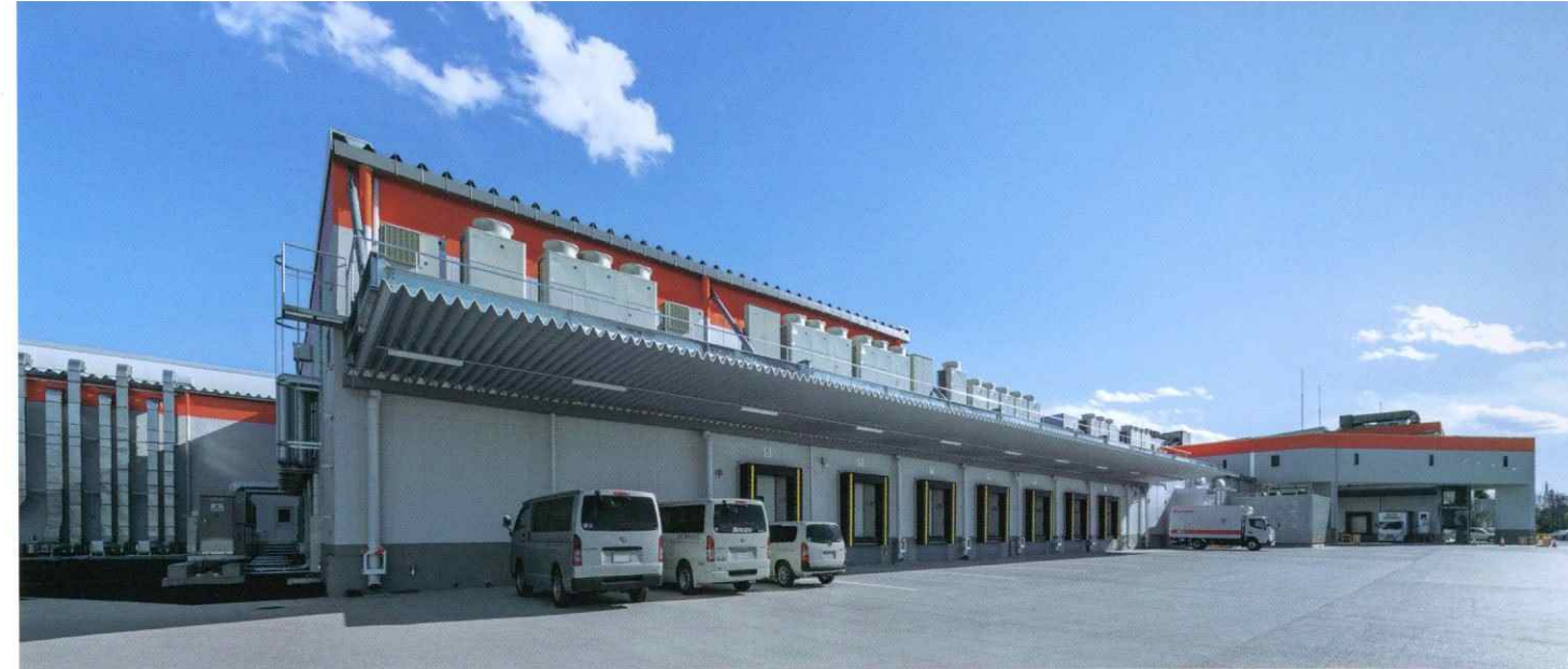
④武蔵野フーズ カムス第3工場 ■電気 ■情報通信
