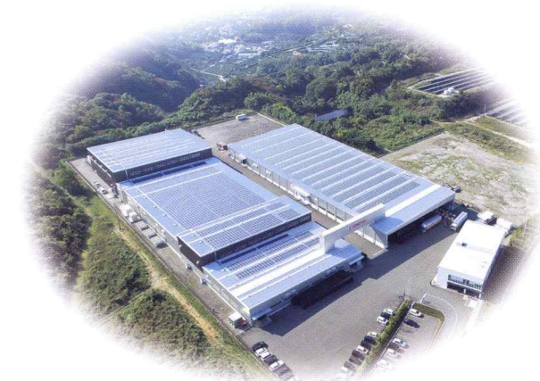
太陽光パネルを使用した和歌山工場
