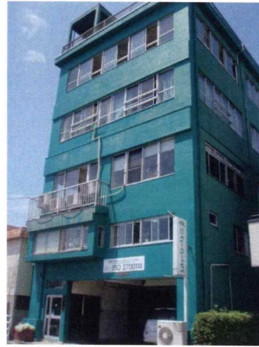
KCS本社ビル
