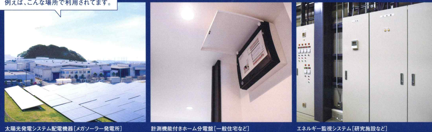
太陽光発電システム配電機器【メガソーラー発電所】
