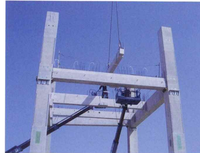
プレキャスト建築現場状況
