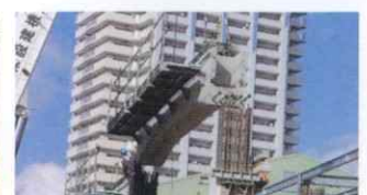
プレキャスト部材架設状況
