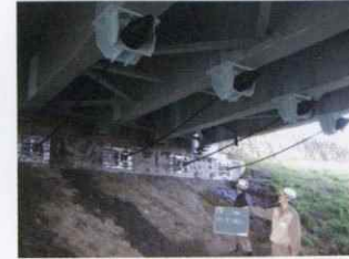
■落橋防止装置設置工事
