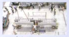
ハーフプレキャスト 施工性確認試験
