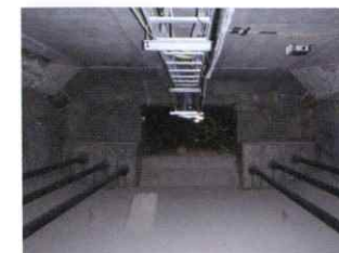
■外ケーブル補強工事
