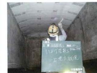
■床版補強工事 (炭素繊維接着)
