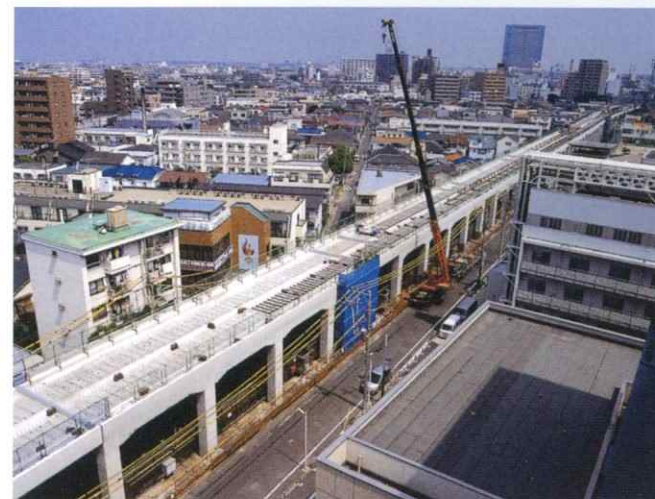
ハーフプレキャスト架設状況
