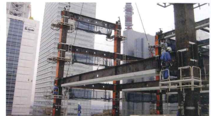
プレビーム建築梁現場状況
