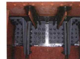
■鋼製脚疲労対策工事
