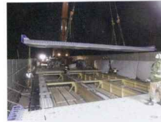
■床版取替え工事 (合理化継手構造)
