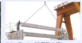
エコマール (地下貯水槽) 施工性確認試験
