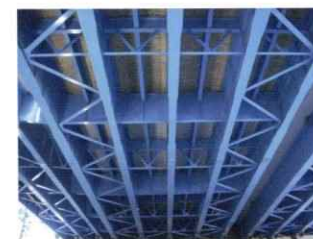
■床版の補修・補強工事 (縦桁増設)
