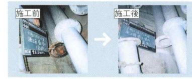
ポンプ室のミニライナー工法による補修 (施工前→施工後)
