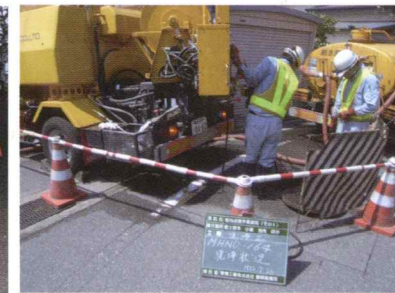
下水管清掃作業
