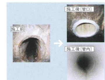
ミニライナー工法による補修(施工前→施工後)
