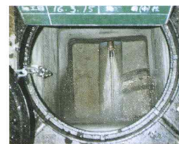
清掃 高圧洗浄機を用いて管内の清掃を行い、堆積物および内面付着物を除去します。
