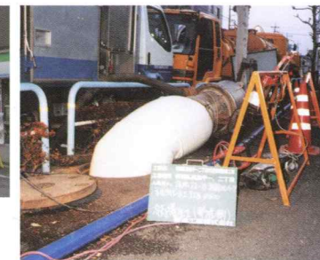
オールライナー工法による補修作業
