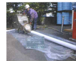
補修1 ミニライナー工法では、補修用の樹脂をエアーを注入したライナーホースを管口に挿入し、反転を開始します。反転完了後、エアーで圧力保持し、蒸気で加熱硬化後、管口でライナーホースを切断し、管口仕上げを行います。
