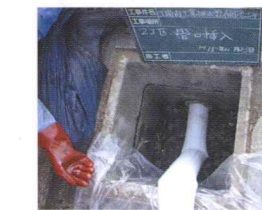
補修2 エアーを注入したライナーホースを管口に挿入し、反転を開始します。反転完了後、エアーで圧力保持し、蒸気で加熱硬化後、管口でライナーホースを切断し、管口仕上げを行います。
