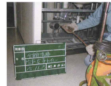
全館清掃作業 洗面系統の横引き管をフレキシロッターを使用し、清掃します。
