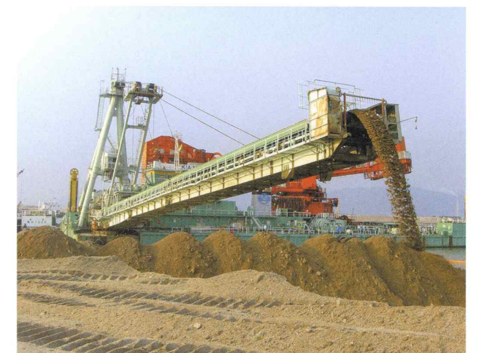
3,000m 3 /hリクレマ船による山土揚土(岩国飛行場移設工事)
