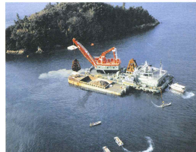
■ 来島海峡大橋下部工工事
