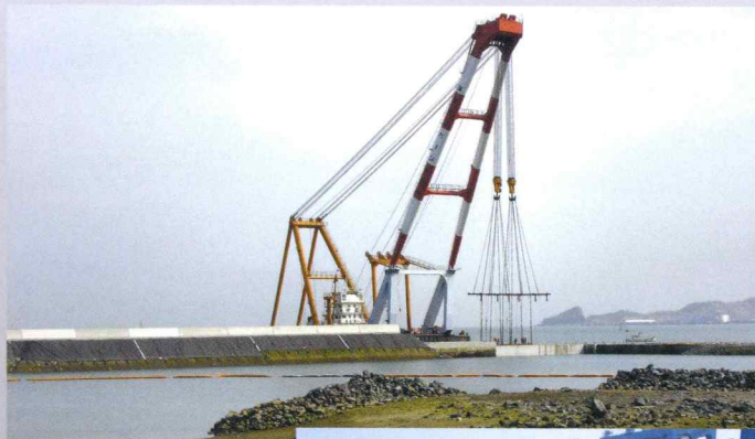
■ケーソン据付（下関港岸壁工事）
