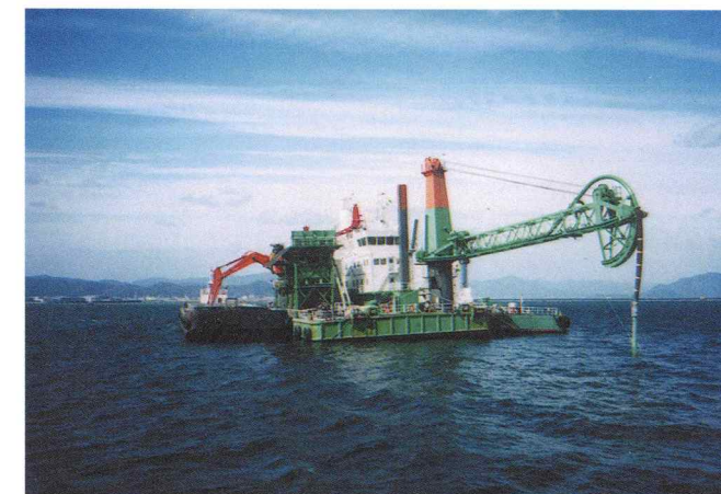
■岩国飛行場滑走路移設岸壁工事
