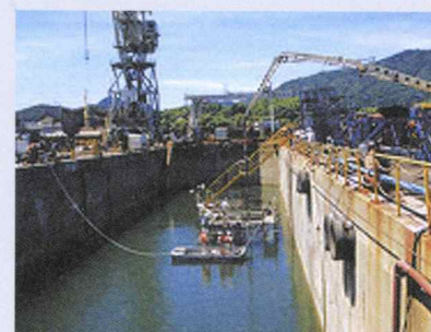
水中打設技術の影響調査
