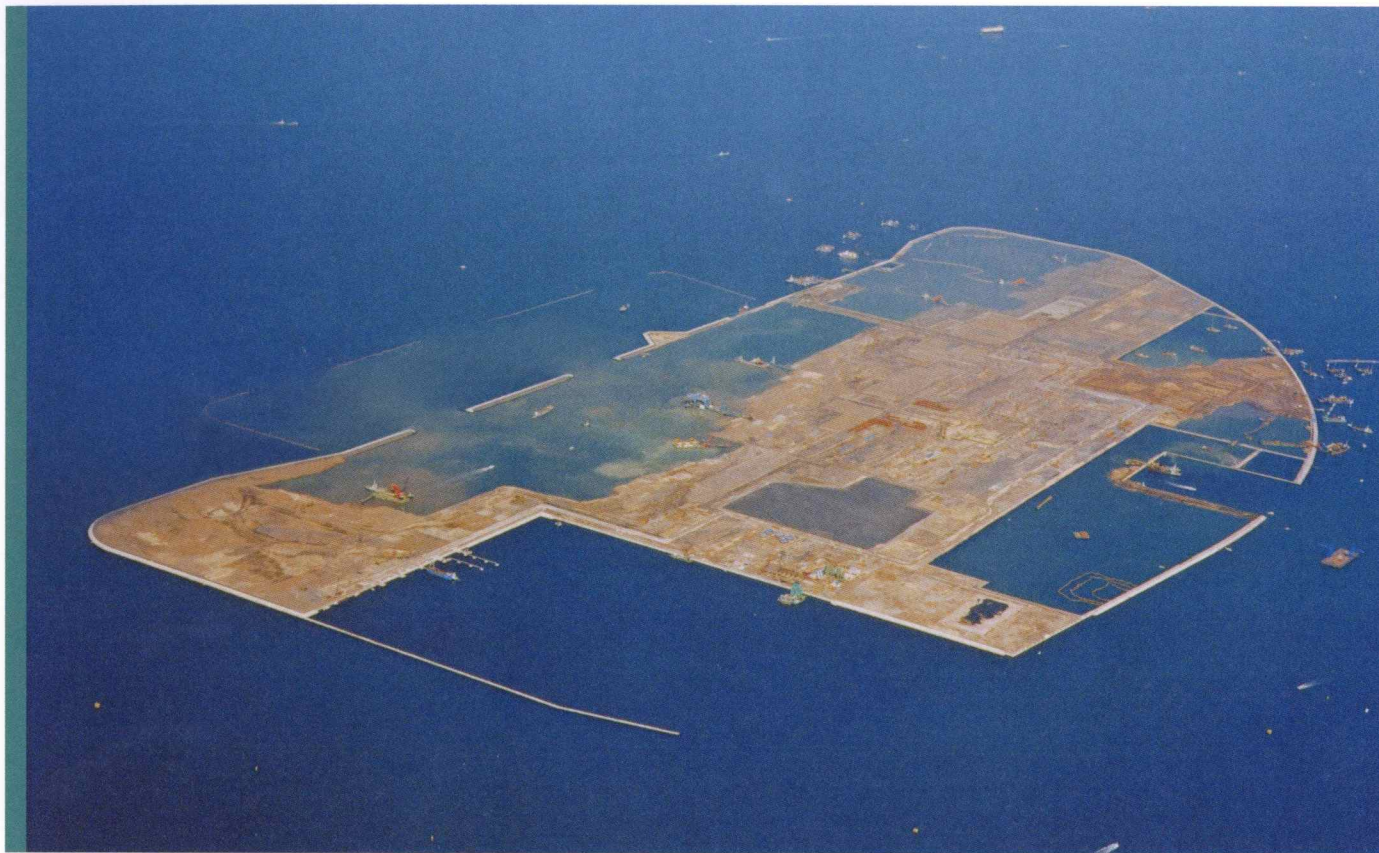
中部国際空港埋立工事(当社リクレマ船8隻稼働)
