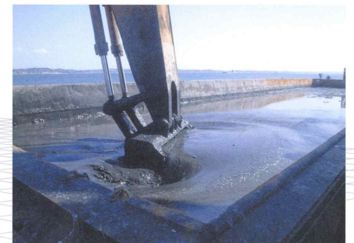
バックホウ式リクレマ船による浚渫土揚土
