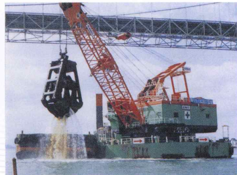
■ 関門航路(早鞆瀬戸地区) 浚渫工事
