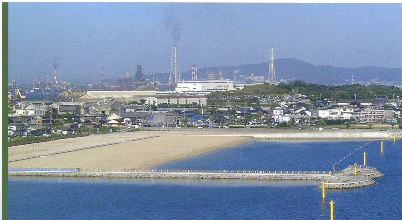
■人工海浜（海岸環境整備工事）
