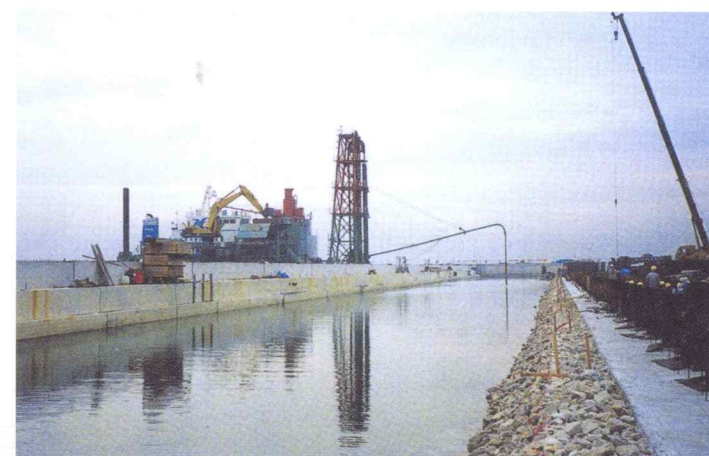
■軽量固化処理土打設状況
