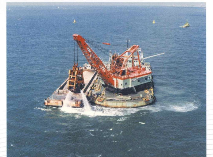
■ 明石海峡大橋下部工工事
