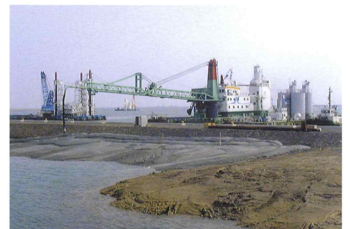
■苅田港新松山地区埋立工事
