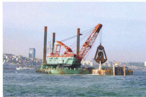
■沈埋トンネル用トレンチ掘削
