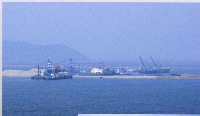
■下関沖合人工島埋立工事
