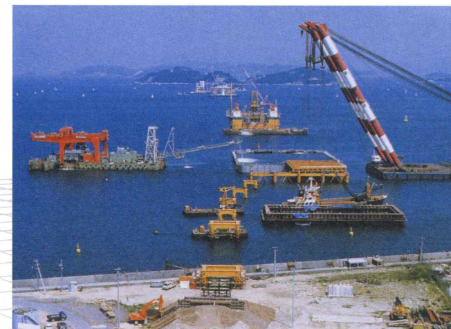
グラブ式リクレマ船による橋脚ケーソン内への骨材投入(本州四国連絡橋)
