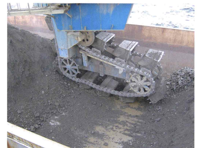
3,000m 3 /hチェーンバケットアンローダ(底ざらえ状況)
