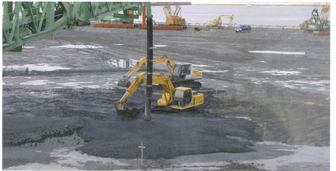
■打設翌日には重機走行可能 (刈田港新松山地区泊地浚渫工事)
