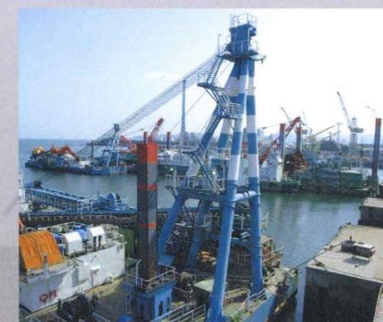
■作業船係船岸壁
