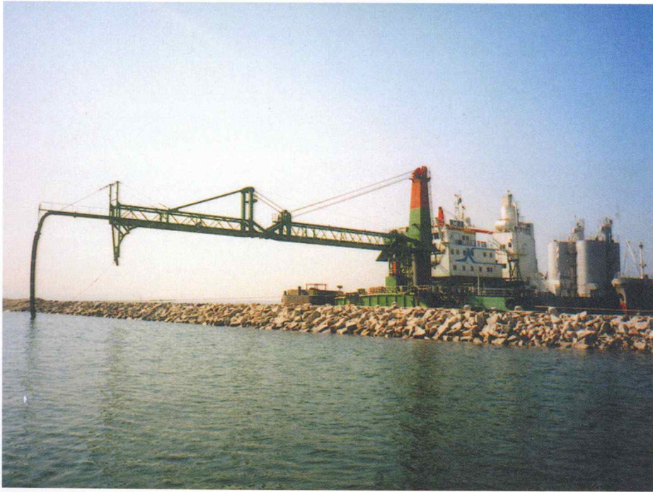
■水中打設 (名古屋港第3PI裏込工事)
