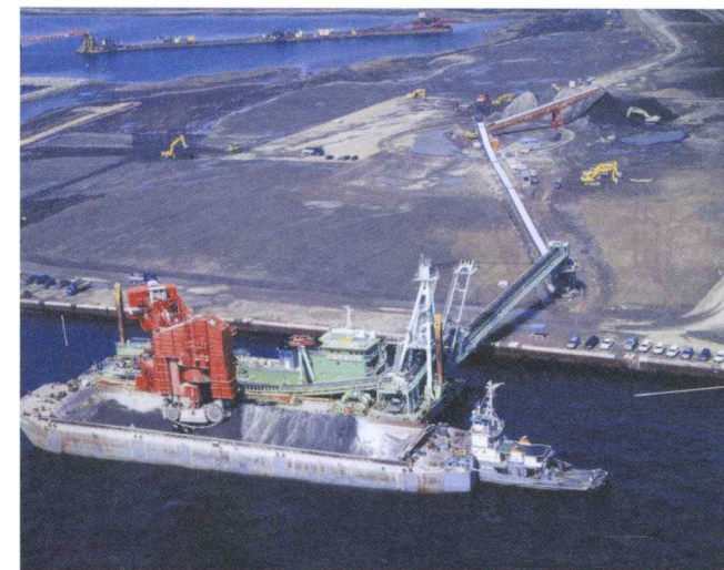
コンベアシステムによる揚土(南本牧埋立事業)
