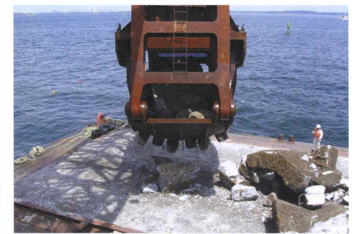
■破碎撤去物積み込み
