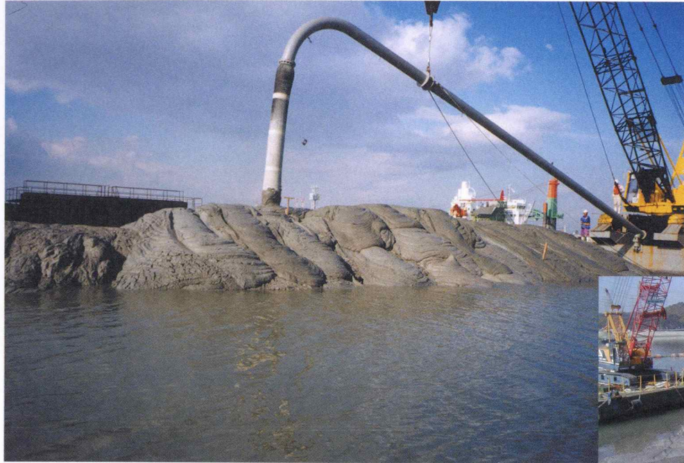
■中仕切り堤 (法勾配1:3) (名古屋港第3PI汚濁防止対策工事)
