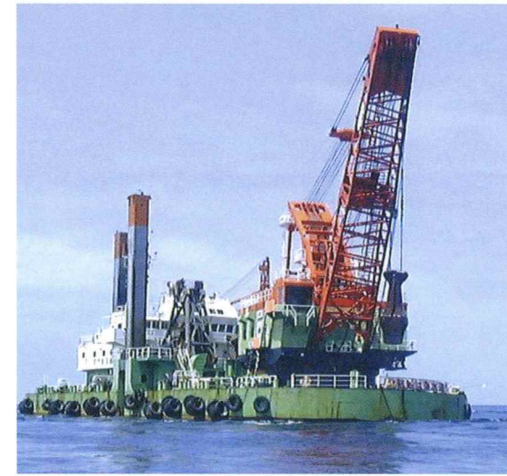
■平戸瀬戸航路浚渫工事（50t重錘による砕岩）
