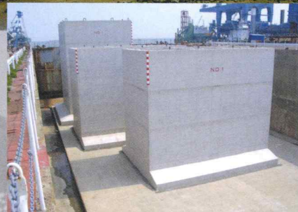
■ケーソン製作（テクノベース内ケーソンドック）
