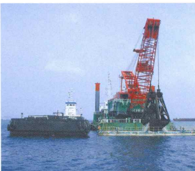
■ 関門航路(六連島西地区) 浚渫工事
