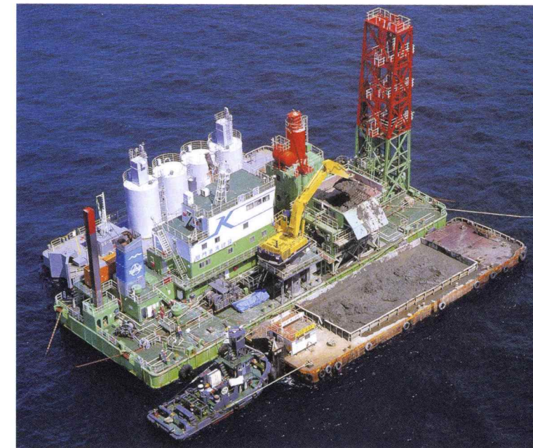
■横浜南本牧埋立工事(土砂漏出防止工)
