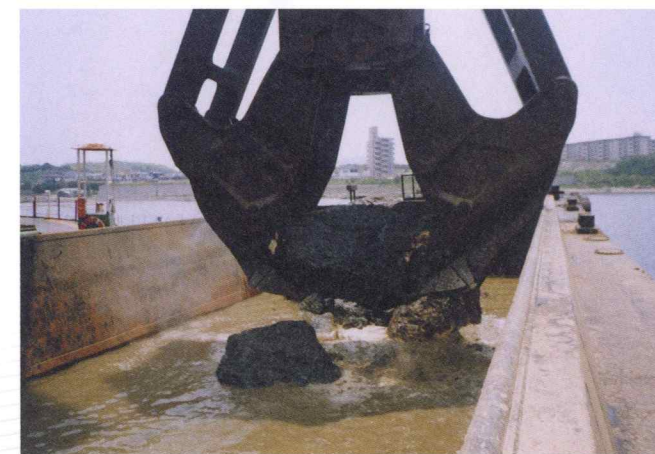
■下関港（新港地区）浚渫工事
