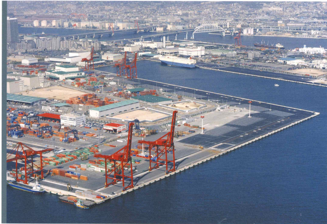
■六甲アイランド岸壁災害復旧工事(阪神淡路大震災復旧工事の一部にプレミックス工法が採用されました。)
