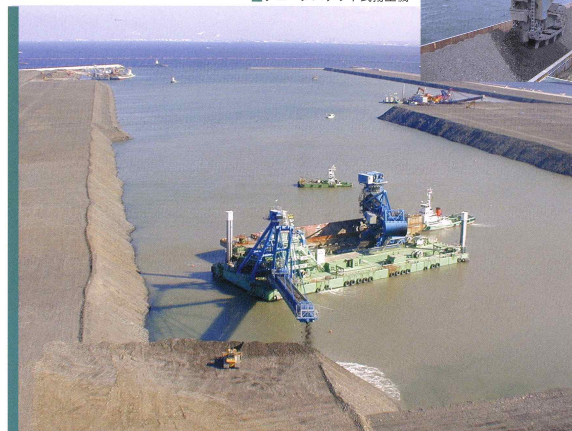
■ 関西国際空港II期 空港島埋立工事 (チェーンバケット式リクレーマ船による狭隘部揚土状況)
