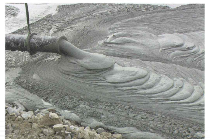
■固化処理土打設状況(圧送管先端部分)
