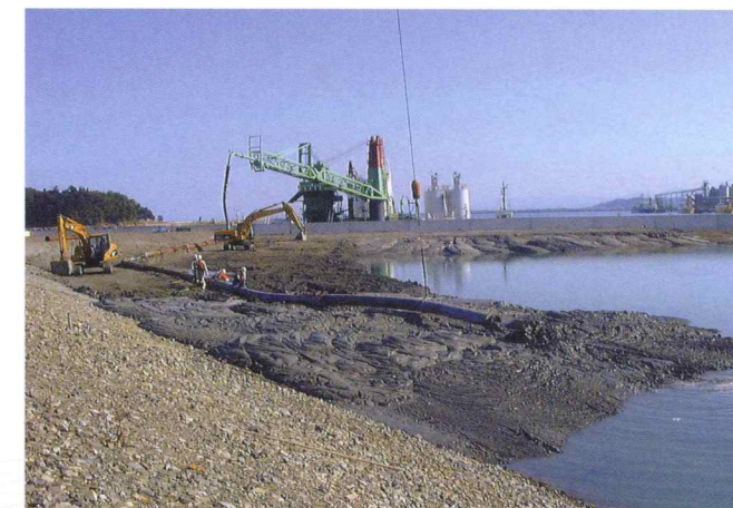
■苅田港本港地区埠頭用地造成工事
