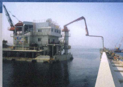
■人工島岸壁工事
