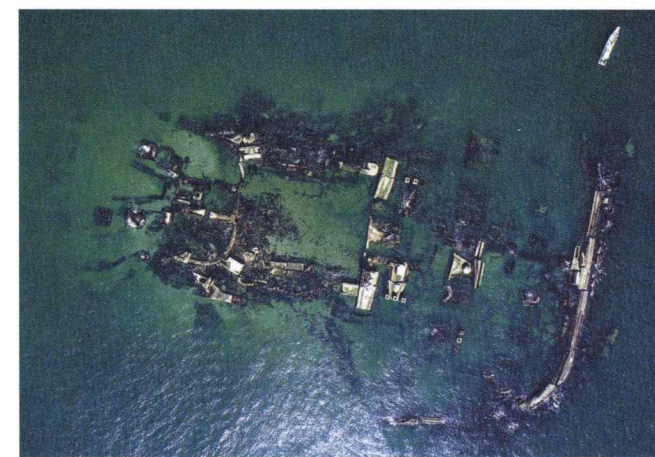
■東京湾口航路第3海堡撤去工事（航空写真）
