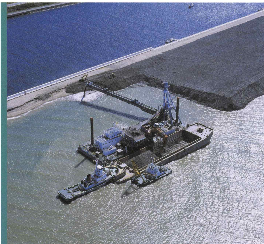
■ 関西国際空港II期 空港島埋立工事 (バックホウ式リクレーマ船揚土状況)
