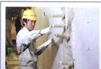
NTTとう道排水管調査・点検工事 排水管内の腐食・漏水・継手部の離脱などを確認し、点検する工事です。
