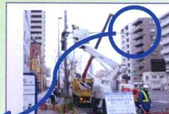
車両感知器取換工事 超音波式や画像式の感知器を用いて交通量の検出を行っています。その感知器を取り替える工事です。
