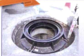
マンホールの鉄蓋取替工事 古くなったマンホールの鉄蓋を新しい鉄蓋に取り替える工事です。
