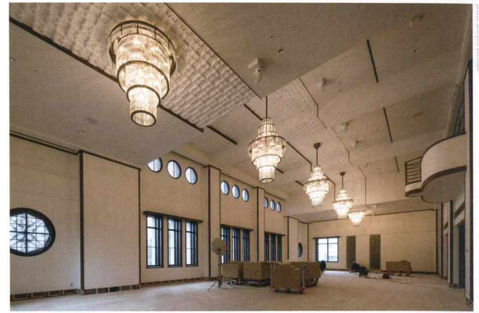
真珠の間(復原、撮影時はフローリング未着手)。シャンデリアも当時の竣工写真や報道写真を手掛かりに、デザインとサイズを再現
