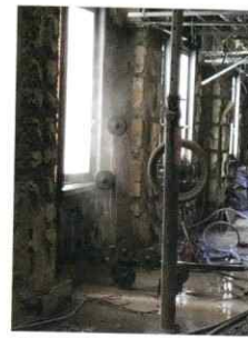
解体工事中。切断するワイヤーソーを繰り出す
