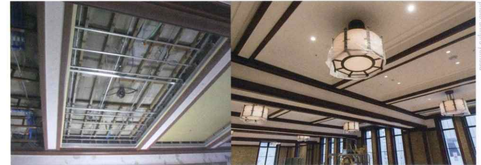
鳳凰の間(復原)の天井保存・補強改修の様子(左)と仕上げ(右)
