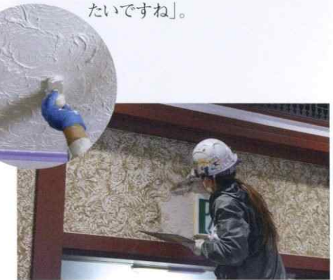
漆喰塗りには専用のコテを開発(左上)。漆喰の上にさらに丁寧な彩色が施されていく
