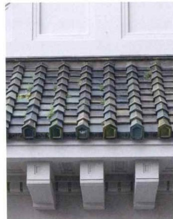
新旧を組み合わせた瓦。上裏はピンネット工法(ネットをアンカーピンで固定し、セメント塗り)で剥落防止を施している
