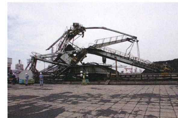
ジブローダーの折損災害
