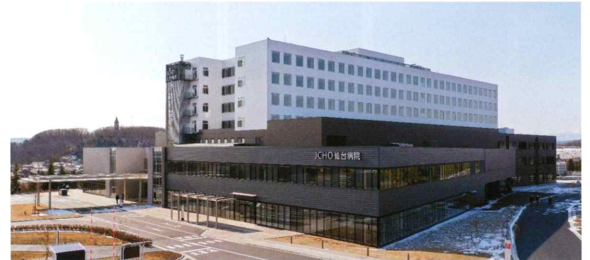
(JCHO仙台病院 令和3年2月完成)
