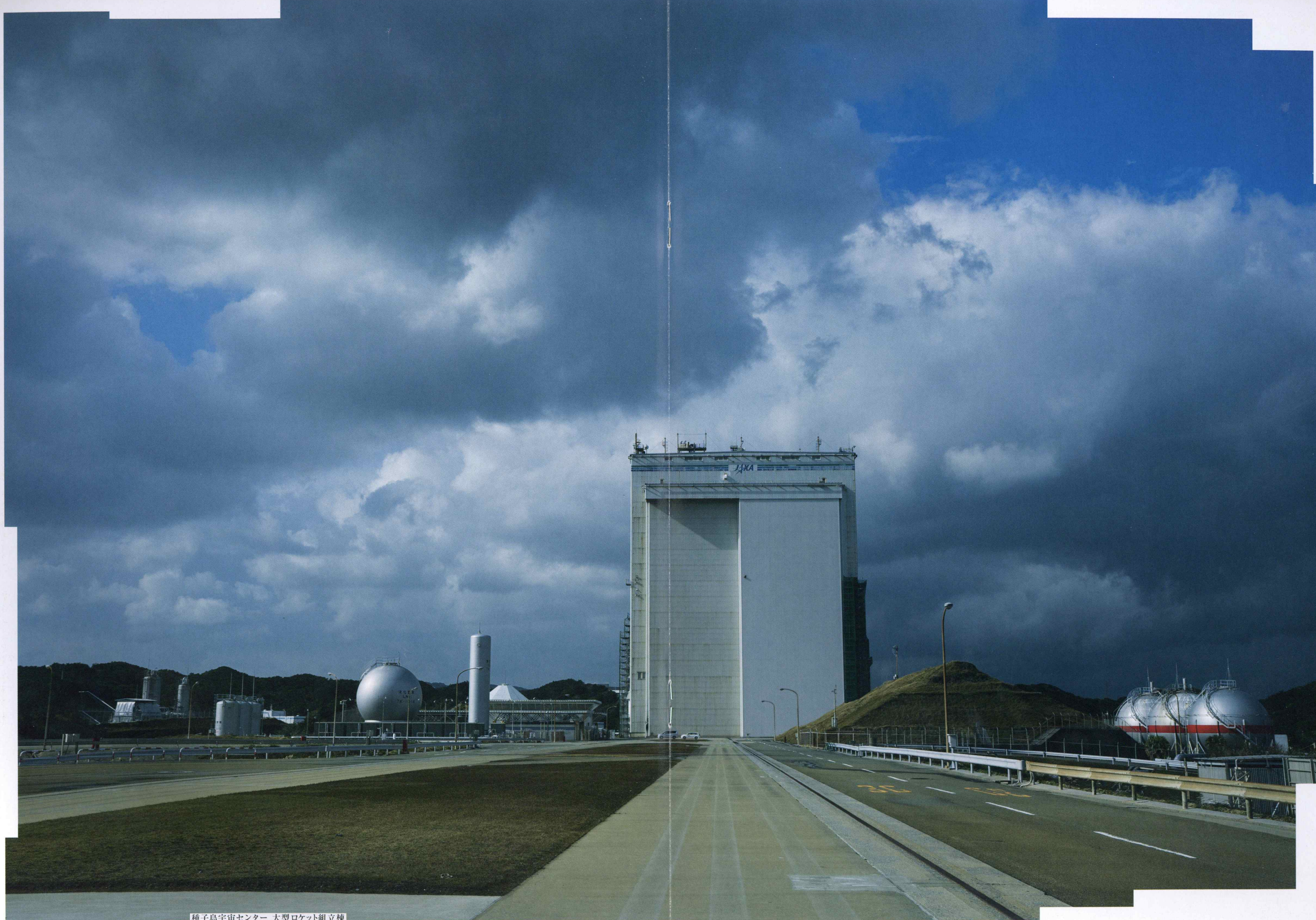
種子島宇宙センター 大型ロケット組立棟
