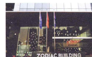
伊豆義ベトナムの入居ビル。
