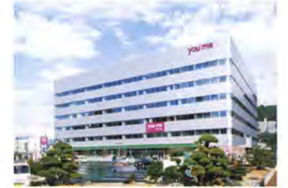
▲オフィスビルの1階
