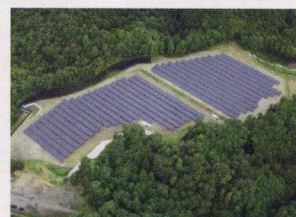
奈良小倉第二太陽光発電所 25,275㎡ / 1.3MW
