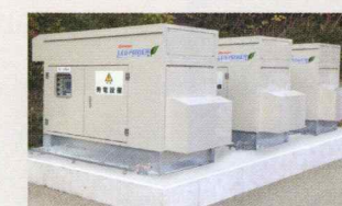
事業所に採用しているLPガス自家発電機
