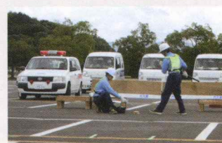
埋設管漏えい検査訓練
