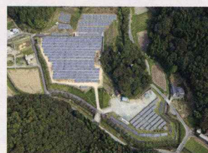
兵庫篠山太陽光発電所 17,798㎡ / 1.3MW
