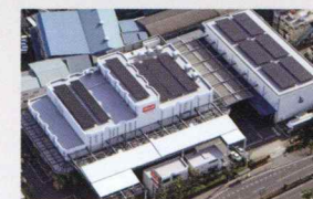
伊丹精米工場 (175.00kW)
