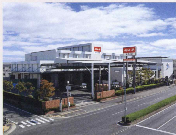
伊丹精米工場
