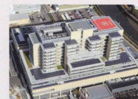
兵庫県立尼崎総合医療センター (174.42kW)
