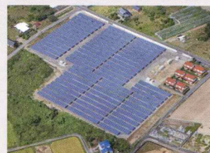
鳥取倉吉太陽光発電所 22,356㎡ / 1.3MW
