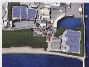
兵庫赤穂太陽光発電所 21,756㎡ / 1.9MW
