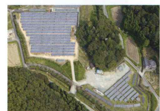
兵庫篠山太陽光発電所 17,798㎡ / 1.3MW
