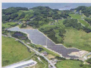
千葉富津太陽光発電所 135,773㎡ / 7.9MW
