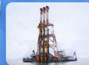
地盤改良工事業
