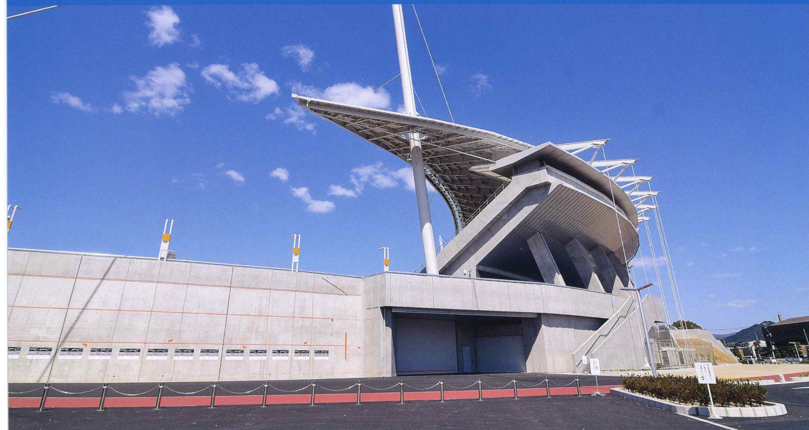
アーチ構造と吊り構造を組み合わせたハイブリッド構造による大屋根の維新百年記念公園陸上競技場。
