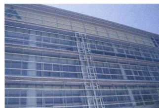
カーテンウォールダブルスキン構造
