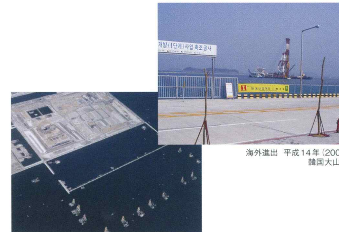
東京港新海面処分場地盤改良工事(左下から右へ3番目 弊社SCP船)
