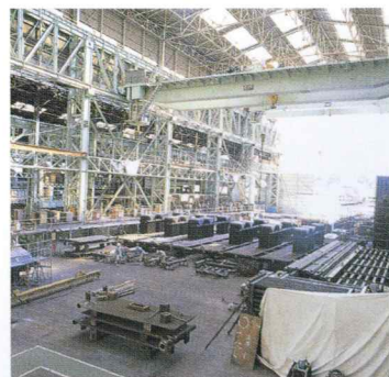
ボイラ工場 (100トンクレーン2基)
