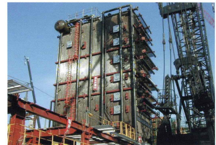
排熱回収ボイラ (横型自然循環式)
