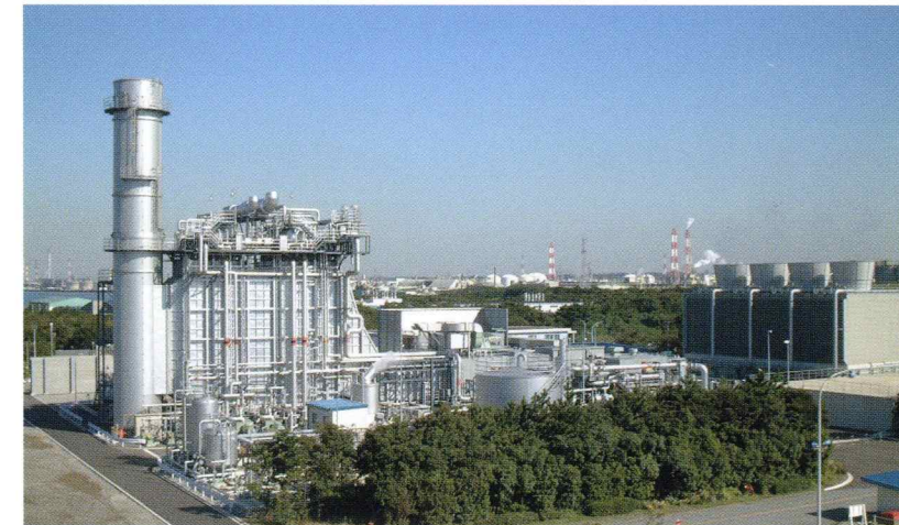
排熱回収ボイラ (横型自然循環式)
