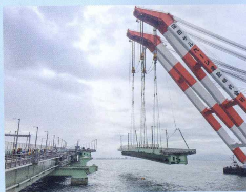
損傷した橋桁の撤去状況
