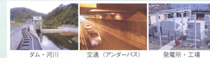
ダム・河川 交通 (アンダーパス) 発電所・工場
