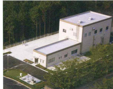
浸出水処理施設
