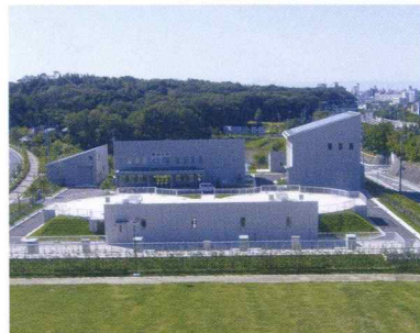
下水処理機械設備
