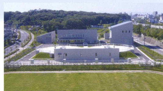
下水処理機械設備
