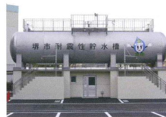
耐震性貯水槽
