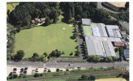
島根第一工場 [操業開始/1970年1月] ●敷地面積/21,877m 2 ●延床面積/6,116m 2
