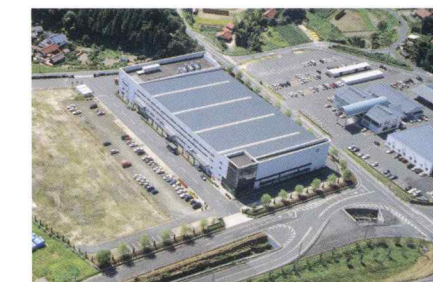
島根第三工場 [操業開始/1994年8月] ●敷地面積/27,825m 2 ●延床面積/12,825m 2
