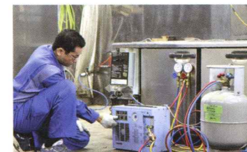
機器廃棄の適正処理、冷媒回収への取り組み Disposing of machines properly, Recovering refrigerants
