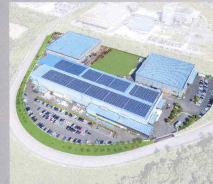
福山北事業所 Fukuyama north plant 土地 Plottage:39,365㎡ 建物 Building:16,609㎡
