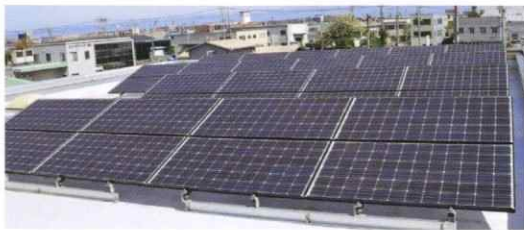
鳥取支店発電所
