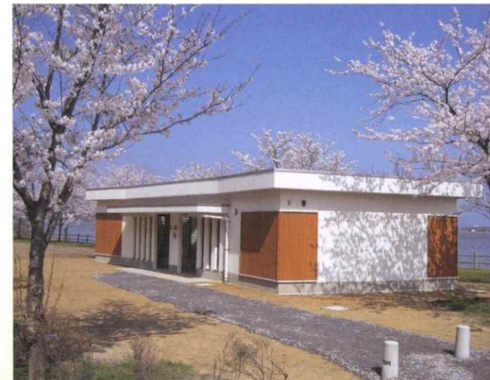
湖山池公園便所新築工事
