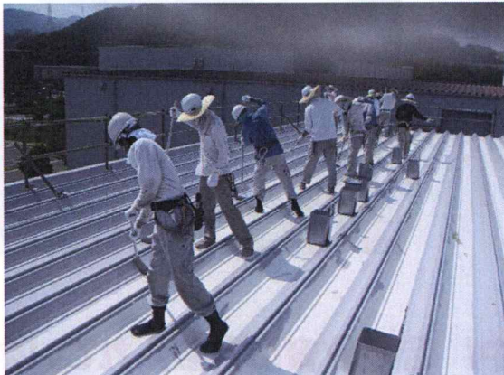
塗装作業風景
