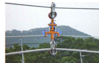
※1 巻上げ式吊金工法
