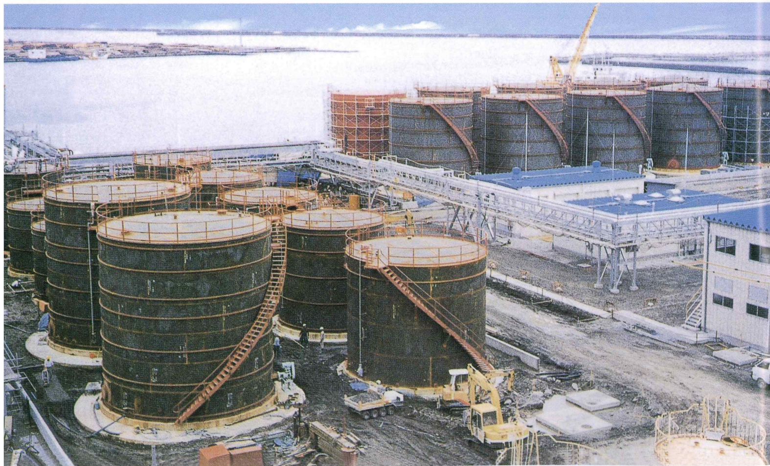
900KL石油貯蔵タンク他 (製作数34基) 900KL OIL TANK
