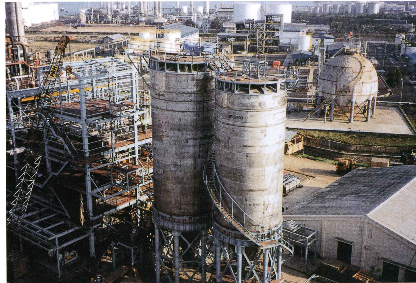
PTAプラント用 850m 3 SUS304サイロ×2基 PTA PLANT SUS304 SILO
