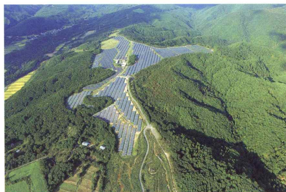
七ヶ宿太陽光発電所(宮城県)
