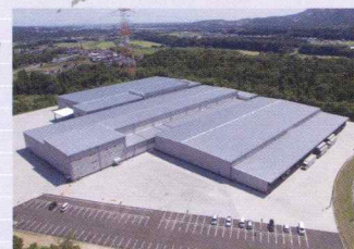
三重第二工場
