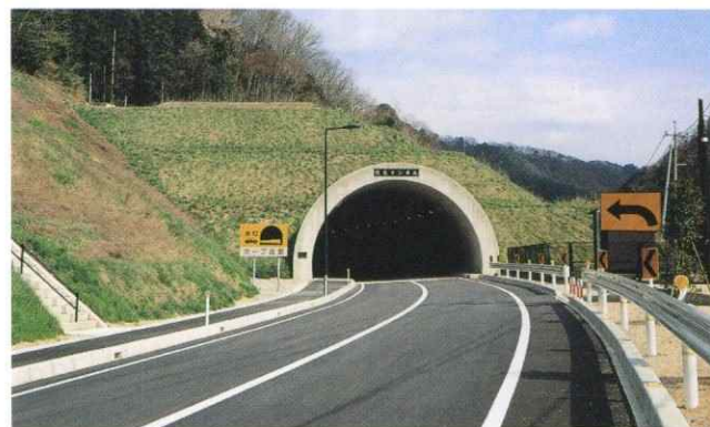
一般国道375号 熊見トンネル（広島県） 一般国道375号は、広島県呉市から島根県大田市に至る陰陽を結ぶ重要な幹線道路である。なかでも最大の難所となっていた県境の山あいにおける熊見トンネルの完成は、交通の安全性・利便性の向上はもとより、地域経済の発展に大きく寄与するものと期待されている（L=732m）。
