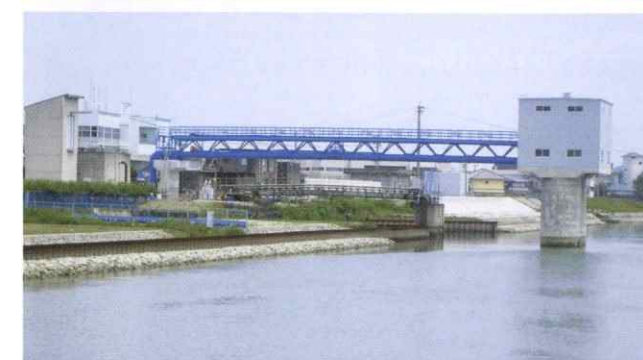
鳴門市取水施設(徳島県) 徳島県旧吉野川において計画・設計した計画取水量60,000m 3 /日の上水道の取水施設です。取水施設は、取水塔、取水ポンプ、水管橋で構成され、取水の安定性や施設の維持管理に配慮した構造になっています。
