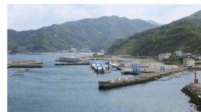
佐賀関漁港整備(大分県) 大分県佐賀関漁港には、衛生管理型漁港として、生け簀付き浮体式係船岸や海水交換型防波堤が整備されています(H23全建賞受賞事業)。
