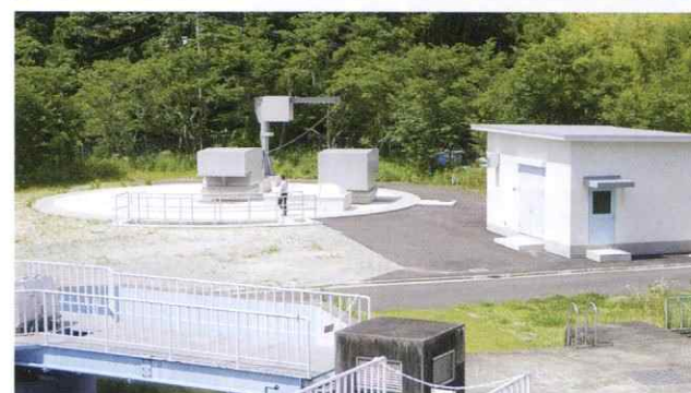
高陽系・戸坂系連絡管整備事業(広島県) 緊急時を含めた相互水運用を可能とするため、2系統の導水トンネルを連絡する連絡管、導水ポンプ施設などの計画・設計を行いました。計画導水量80,000m 3 /日の施設で、導水ポンプ場はニューマチックケーソンで構築した内径16m、深さ15mの地下3階構造になっています(H26全建賞受賞事業)。
