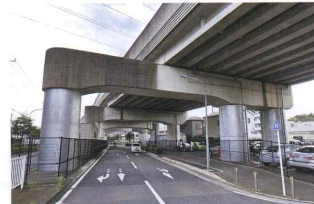
横浜市営地下鉄 耐震補強 (神奈川県)
