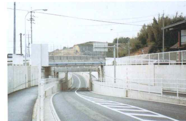
JR山陰本線 直江新川線立体交差 (島根県)
