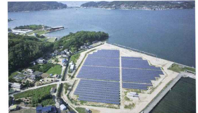
百島太陽光発電プロジェクト（尾道市） 近年注目される再生可能エネルギーの普及に向けて様々な業務サービスを提供しています。本プロジェクトでは計画・設計、地質調査、土木施工監理を行い、供用開始まで支援しました。
