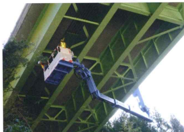
橋梁定期点検(橋梁点検車による近接目視)
