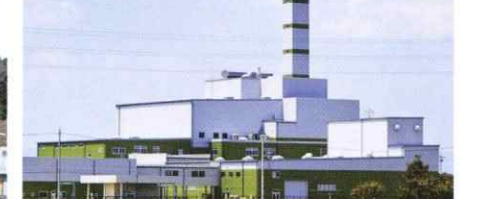
滋賀県近江八幡市 環境エネルギーセンター整備事業
