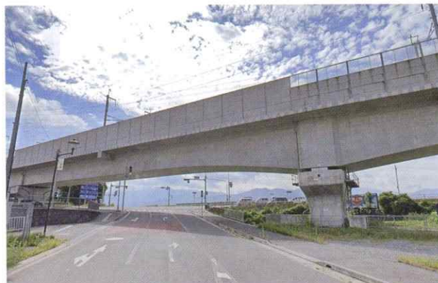
北陸新幹線 中島橋りょう (長野県)
