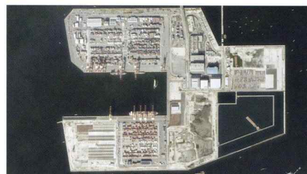
南本牧ふ頭整備(神奈川県) 横浜港南本牧ふ頭は、増大するコンテナ貨物や大型化する船舶に対応するため、水深16mの我が国最大級のコンテナバースを備えています。
