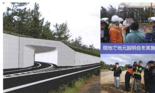
北条道路予備設計業務（鳥取県） 従来は図面や3次元模型を用いた地元説明会を行っていた。現在では3次元設計データを基に、現地で実寸大のモデルを現実空間に重ねて確認できるAR技術を活用することによって、よりいっそうわかりやすい説明が可能となった。
