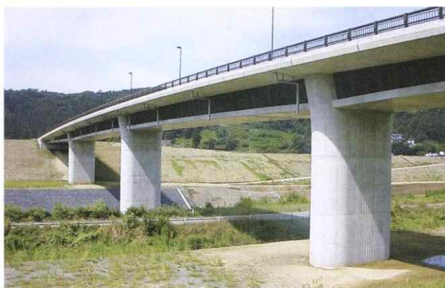
鶴巻橋 (岩手県) 軟弱地盤上に位置するため、死荷重軽減を目的として波形鋼板ウエブPC箱桁橋を採用。さらにラーメン橋として耐震性の向上と建設コストの縮減を図った。
