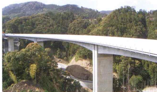
清水谷第一高架橋 (和歌山県) 那智勝浦道路の始点部の深い谷部に位置するPC3径間連続曲線ラーメン箱桁橋(張出し架設)(平面曲線R=150m)。
