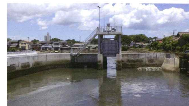
島原港樋門(長崎県) 島原市の島原港霊南地区の堤防整備に伴い、計画・設計した幅3.0m×高さ3.4mの樋門です。海岸堤防、ポンプ場、排水樋門を総合的に整備することにより、高潮被害を防止しています。
