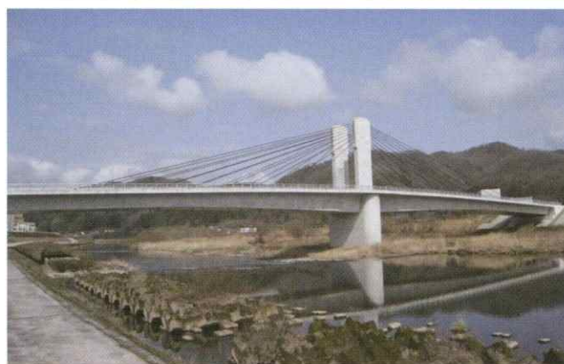
願橋 (広島県) 河川内における上下部工の施工性と地域のランドマーク性を考慮して、エクストラード橋を採用した。
