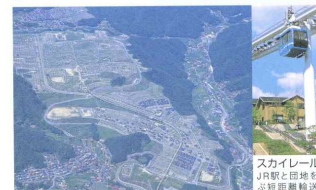
スカイレール JR駅と団地を結ぶ短距離輸送システム（スカイレール）を我が国で初めて導入。
