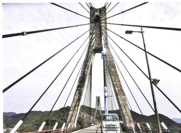
橋梁定期点検(高所作業車による近接目視)
