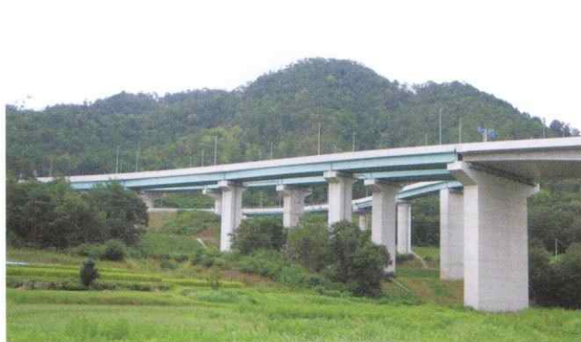
志和インター線橋梁 (広島県) 志和インター線は山陽自動車道志和ICと国道2号のスムーズな接続を目的として計画された路線。国道2号に対して交差・流入・流出する3本の鋼橋を設計。
