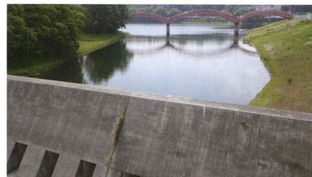
流域治水(広島県) 福山市の市街地を流れる手城川において、春日池への洪水調節機能の付与(写真)、河道の拡幅、排水機場の新設等を計画、設計しています。
