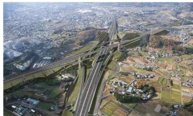
新東名高速道路・伊勢原JCT（神奈川県） 日本の大動脈であり、ダブルネットワークによる渋滞緩和など安全で快適な走行を目指す新東名と現東名。これらが結節する伊勢原JCTは相互の行き来を可能にし、災害など緊急時の代替路線を確保するなど、ネットワークを形成するうえで最重要な拠点。
