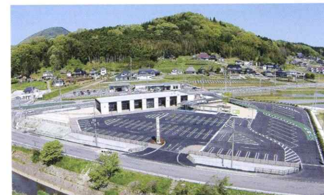
道の駅世羅プロジェクト（世羅町） 魅力的な施設の創出に向け、駅舎（建築施設）をはじめとして、土地造成・外構を含めた必要な施設に関して、各種調査、計画・設計、施工監理、関係課協議を実施し、総合的な業務支援を行いました。
