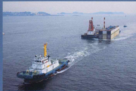
ハイブリッドケーソン曳航(津～衣浦)
