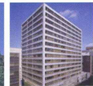
九州本部 福岡天神センタービル
