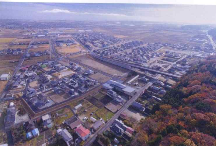
平成25年度 債務負担行為 請1号 新山下駅周辺地区市街地整備工事外[2016年 宮城県]
