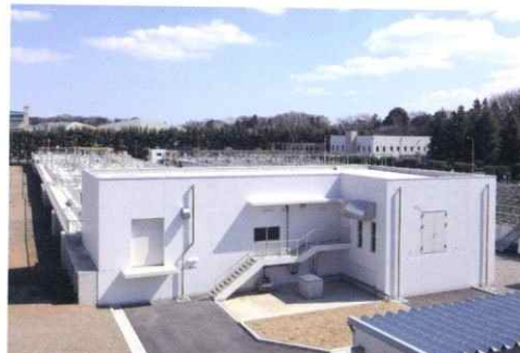
小山市小山水処理センター[2010年 栃木県]
