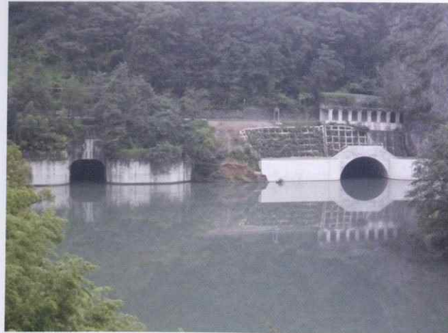
犀川河川トンネル[2014年 長野県]
