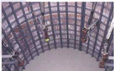
杭頭パイプレータの設置状況
