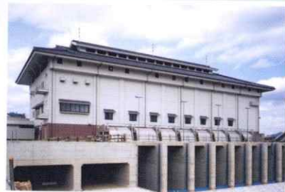
巨椋池排水機場・樋門[2004年 京都府]
