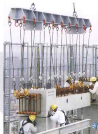
プレキャスト工法による施工 (FHRC工法の例)
