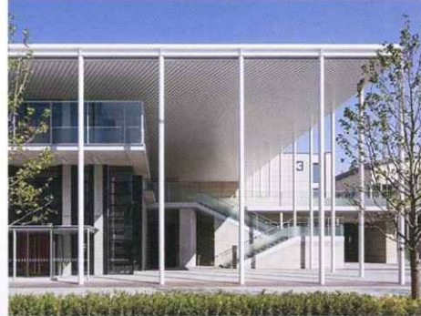
広島修道大学3号館[2013年 広島県]
