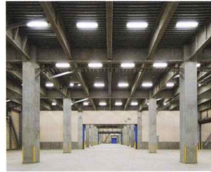
ハイブリッド建築技術による物流センター内部
