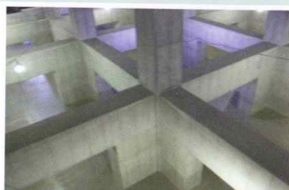
4号公園地下調整池[2011年 埼玉県]
