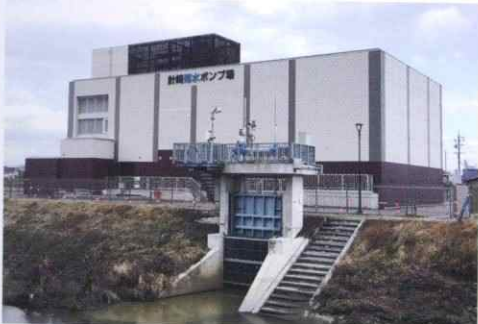
針崎雨水ポンプ場[2014年 愛知県]
