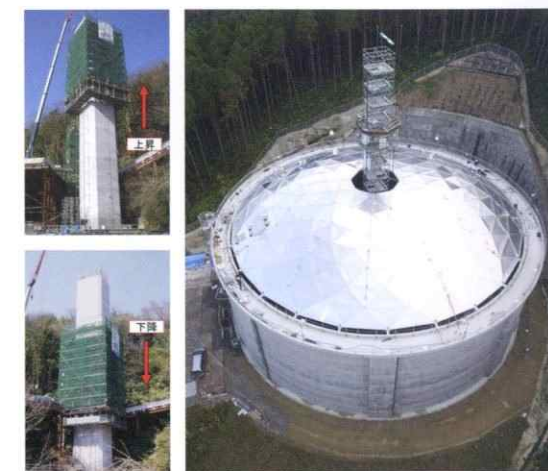
アルミドーム屋根架設の例
