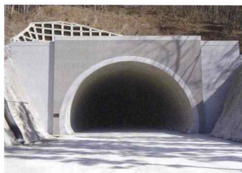
国道115号 円測トンネル[2017年 福島県]
