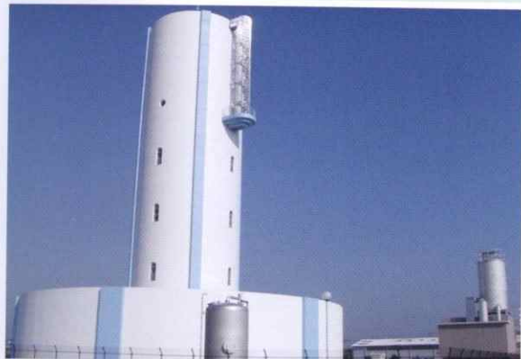
しらさぎ配水場[2010年 栃木県]
