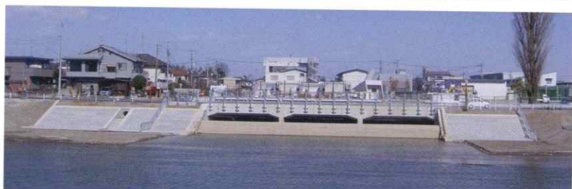
外郭放水路第5立坑流入施設[2007年 埼玉県]
