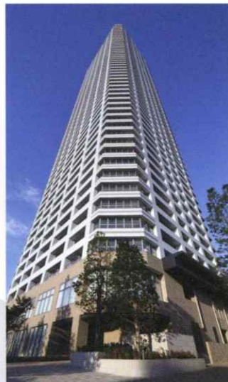
超高層RC技術による施工例
