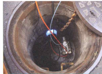
下水道管路更生工事
