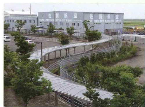
▲佐賀空港 通路用シェルター設置工事
