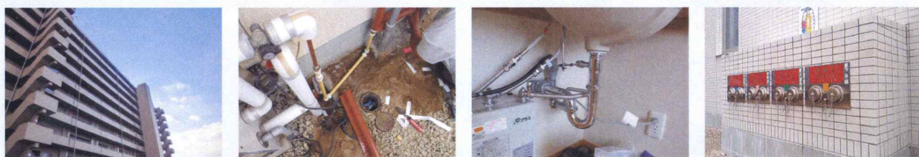
給排水設備工事 新築住宅給排水工事 水道修理工事 消火設備工事
