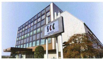
本社・本社別館：東京都中野区 支店：札幌、名古屋、大阪、福岡
