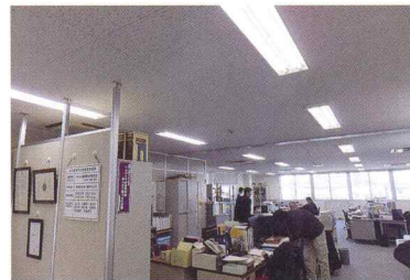
(施工例) 蛍光灯代替LED照明
