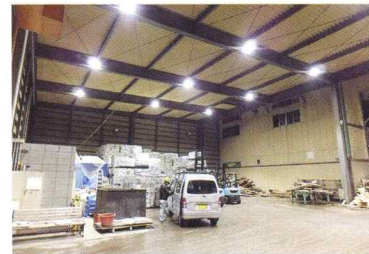
(施工例) 水銀灯代替LED照明
