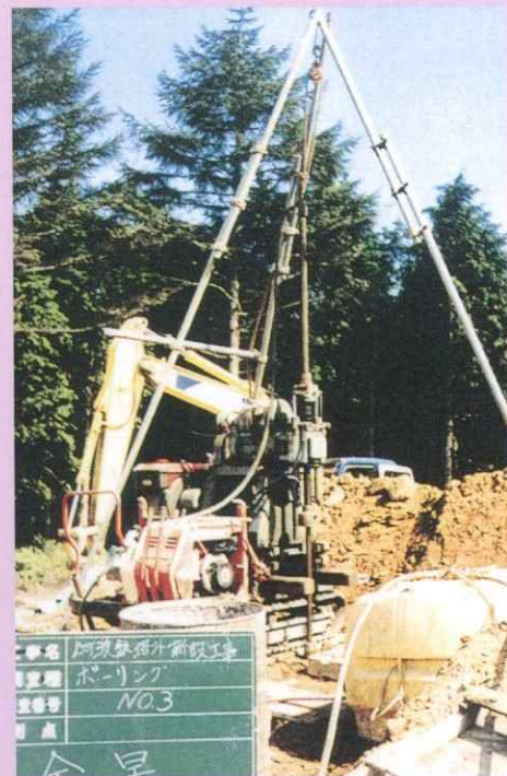
▲地質調査 Geological survey
