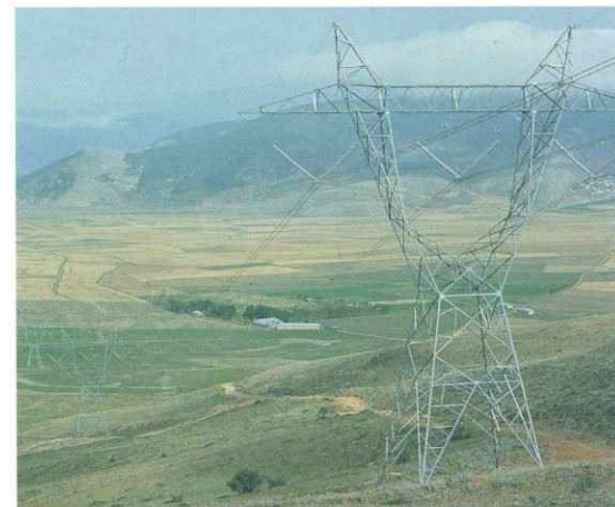
▲テヘラン〜ネカ線 (イラン) Tehran-Neka transmission line towers (Iran)
