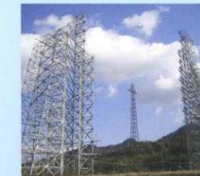
▲鉄塔載荷試験 Tower loading test
