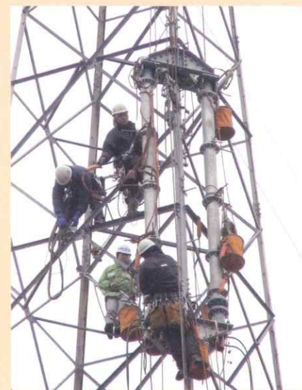
▲鉄塔ジャッキアップ工法 Tower juck-up method
