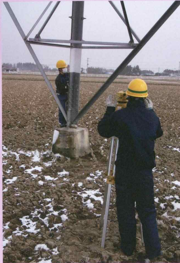
▲基礎不同変位調査 Survey for uneven foundation displacement
