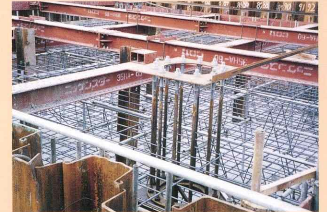
▲基礎工事 Anchor setting work
