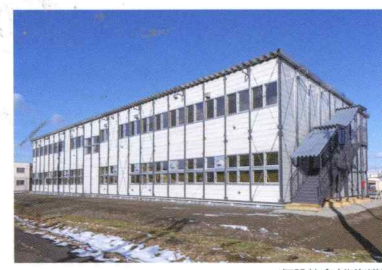
仮設校舎(北海道)
