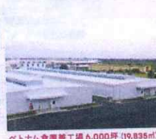
ベトナム倉庫兼工場 6,000坪 (19,835㎡)
