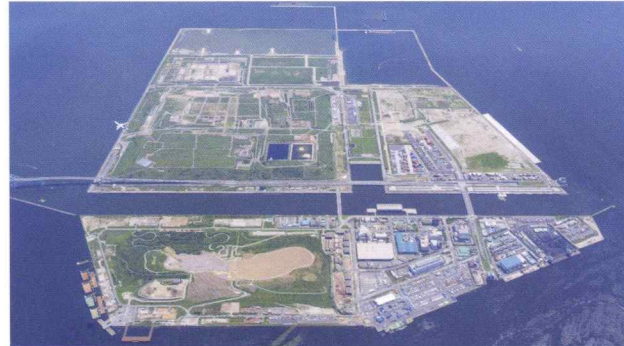
新海面処分場土砂仮置送泥(埋立)工事 [東京都江東区]
