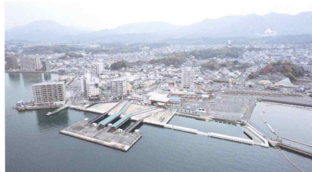
地方港湾 厳島港(宮島口地区)みなとの賑わいづくり事業 埋立工事 [広島県廿日市市]
