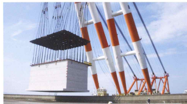
東予港中央地区岸壁(-7.5m)築造工事 [愛媛県西条市]
