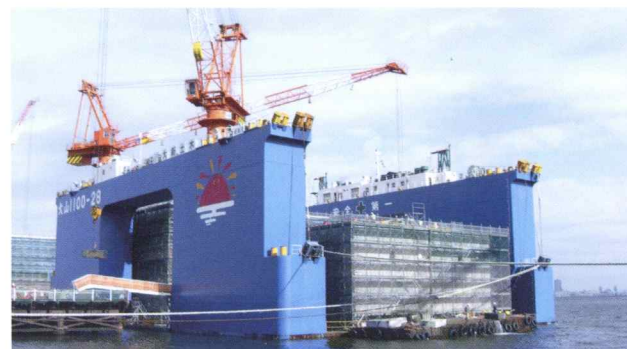
伊豆諸島ケーソン(5,200t)製作工事 [東京都江東区]
