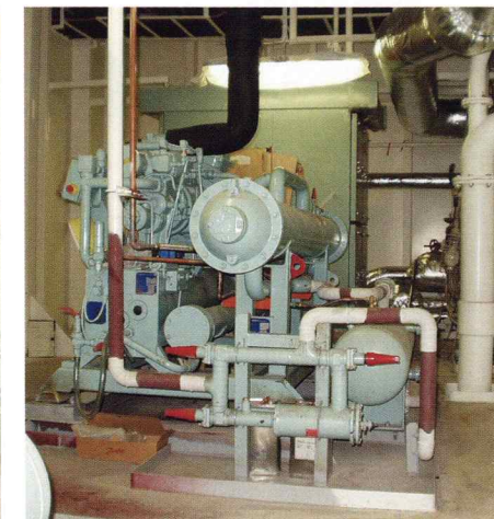
空気調和装置 (Air-Conditioner) チラーユニット (スクルー機) Screw Chiller
