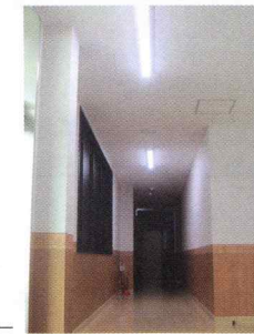
LED照明/人感センサー
