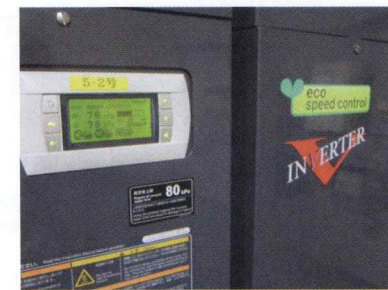
〈インバーター化〉 真空ポンプのエア使用量に応じてポンプ回転数をインバーター制御することで電気使用量を約30%削減。
