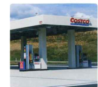
ガステーション
