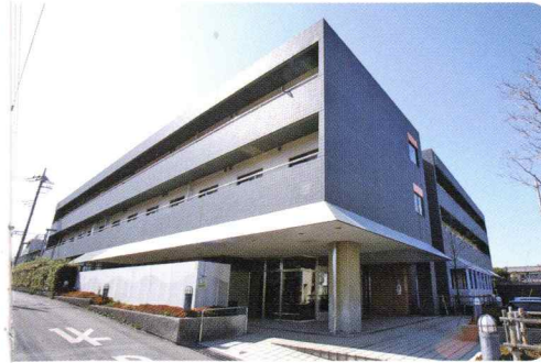
サービス付き高齢者向け住宅「あおぞら」(埼玉県狭山市)
