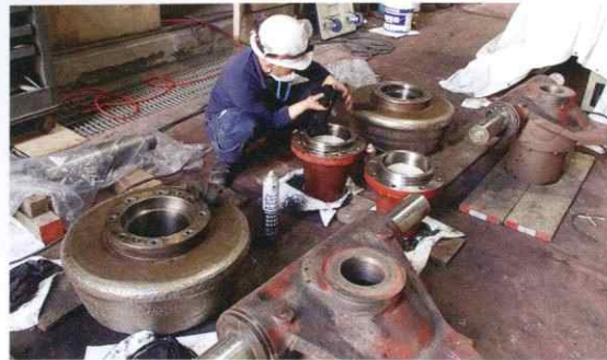
ミル分解整備工事
