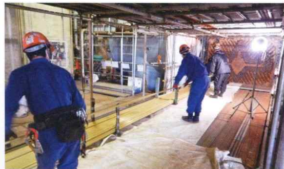
復水器チューブ更新工事
