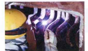
熱交換器小径配管溶接工事
