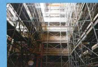
ボイラー炉内足場架設工事
