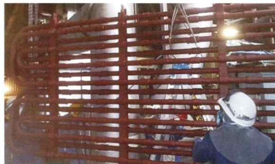
節炭器パネル管更新工事
