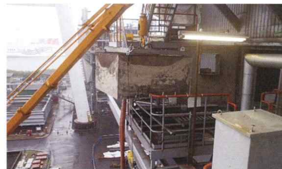
脱硝触媒更新工事
