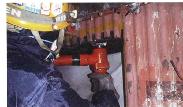
ボイラーチューブ開先加工作業
