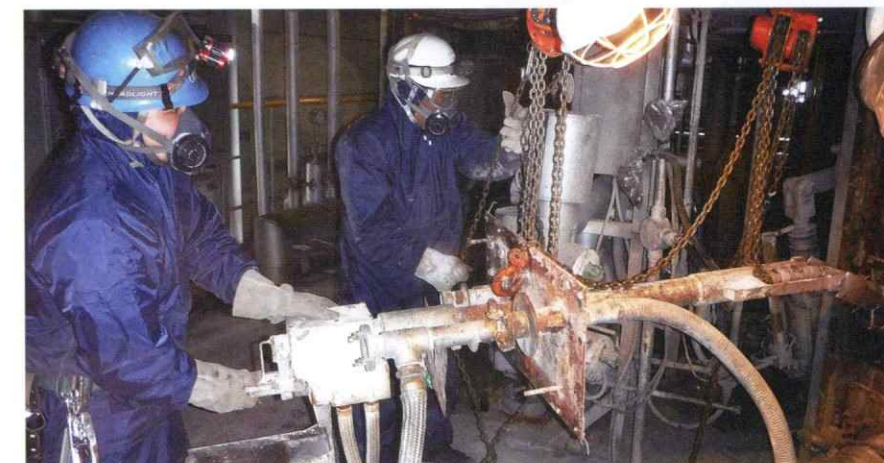
油圧バーナー更新工事
