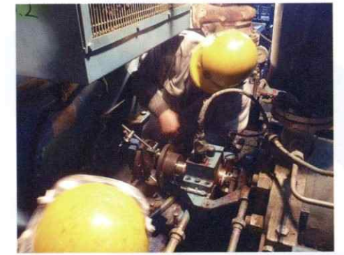
給水ポンプセンターリング作業
