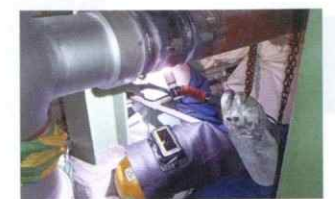
給水配管一部更新溶接工事
