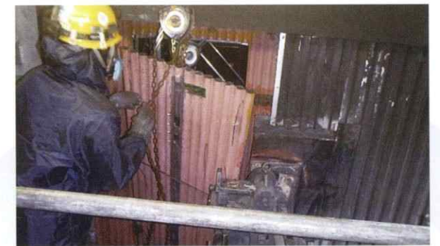
ボイラーチューブパネル更新工事
