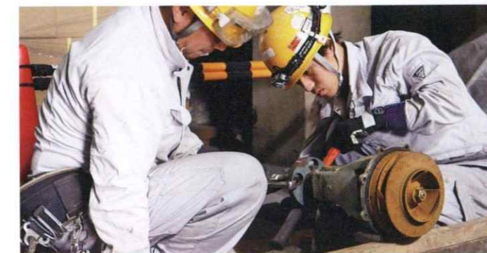
給水ポンプ分解整備
