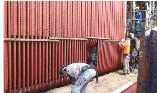
後壁管一式更新工事
