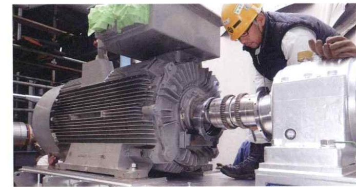
誘引通風機 (IDF) 更新工事
