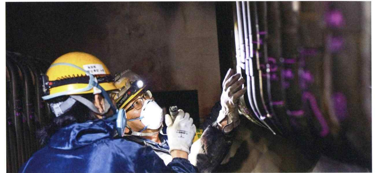
ボイラーチューブ表面目視点検
