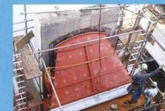
煙道ダクト更新工事
