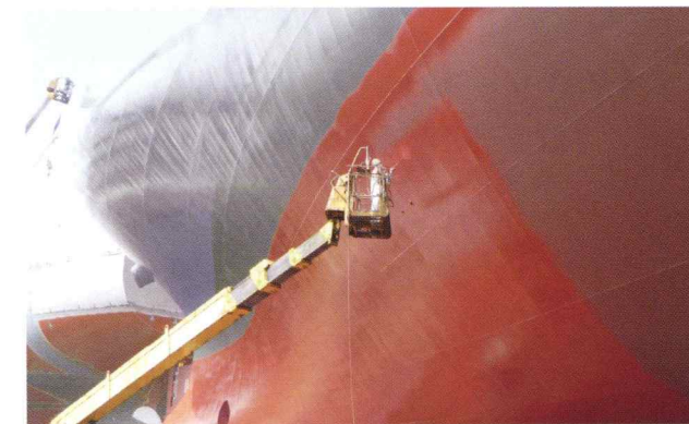
船底防汚塗料の塗装
